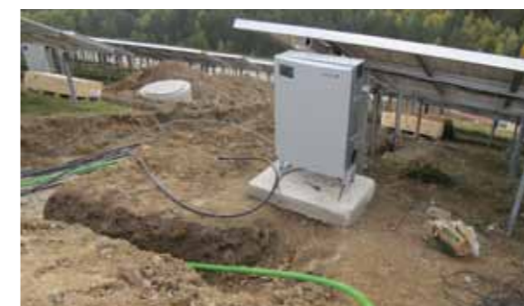
Verkabelung Wechselrichter/Module
